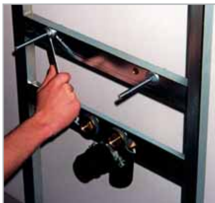
Die Gewindestangen zur Befestigung der Keramikkörper auf den geforderten Abstand positionieren.
