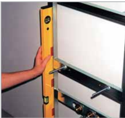
Das Element wird durch Lockern der Mutter der Wandbefestigung in der Tiefe ausgerichtet.
