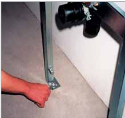
Element mit dem mitgelieferten Befestigungs-Set an Wand und Boden befestigen.
