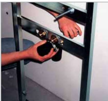
Wasseranschlüsse und Abläufe auf die gewünschten Abstände einstellen.
