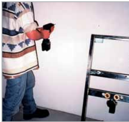
Bohren der Löcher für Wand- und Bodenbefestigung.
