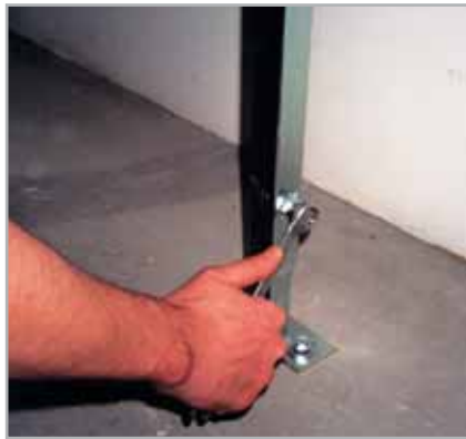
Element in der Höhe ausrichten.
