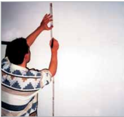
Wand- und Bodenbefestigung bestimmen und markieren.
